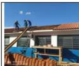
Imagem 04: Troca de telhas.
