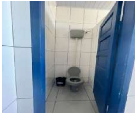
Imagem 31: Reforma dos banheiros feminino e masculino (estudantes).
