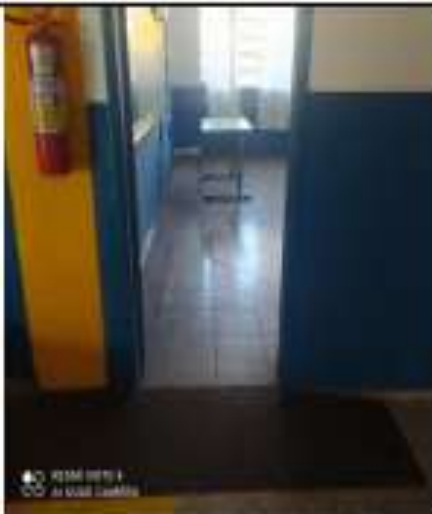
Imagem 19: Rampas de acesso.
