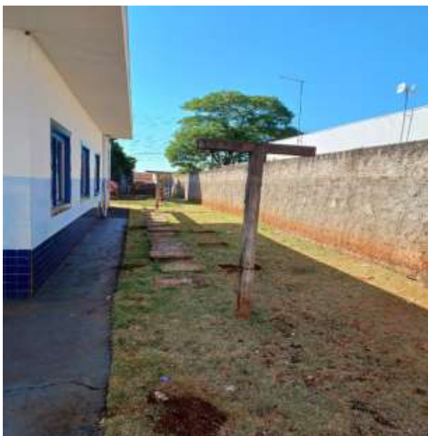
Área ao entorno das salas de aula
