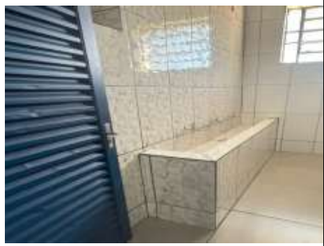
Imagem 34: Reforma dos banheiros feminino e masculino (estudantes).
