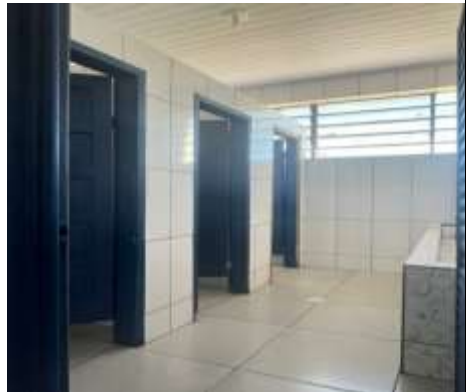
Imagem 28: Reforma dos banheiros feminino e masculino (estudantes).
