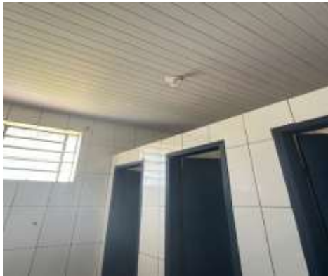
Imagem 27: Reforma dos banheiros feminino e masculino (estudantes).
