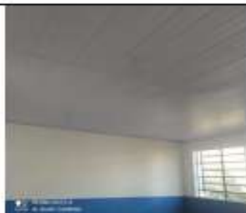
Imagem 02: Troca de forro e pintura.
