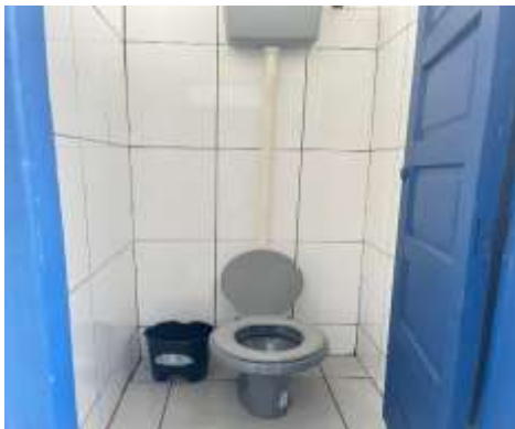
Imagem 30: Reforma dos banheiros feminino e masculino (estudantes).
