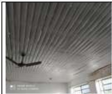
Imagem 01: Forro antes da reforma.
