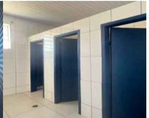
Imagem 29: Reforma dos banheiros feminino e masculino (estudantes).
