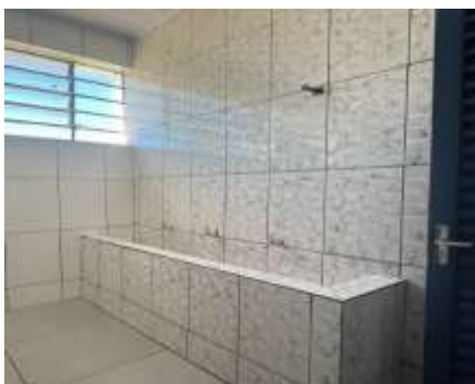
Imagem 33: Reforma dos banheiros feminino e masculino (estudantes).
